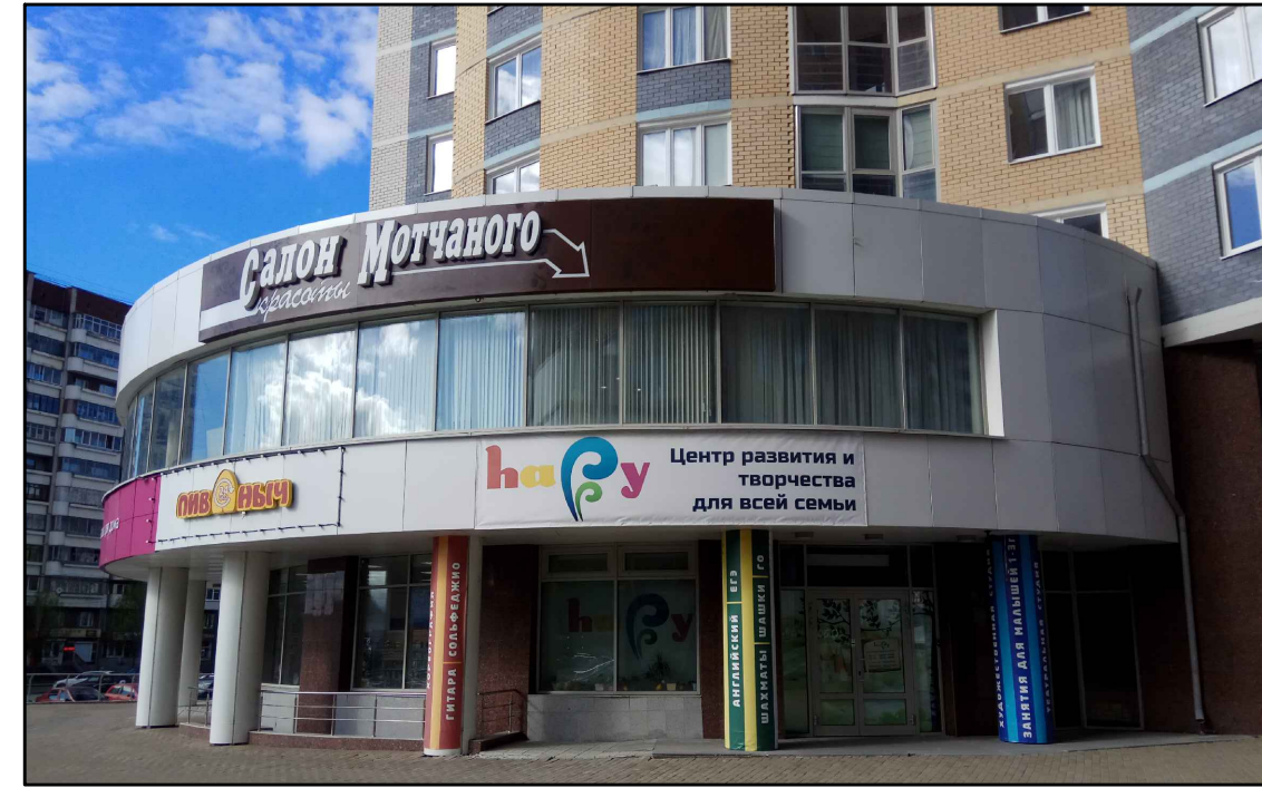
Вид № 5. Общий вид на нежилые помещения
