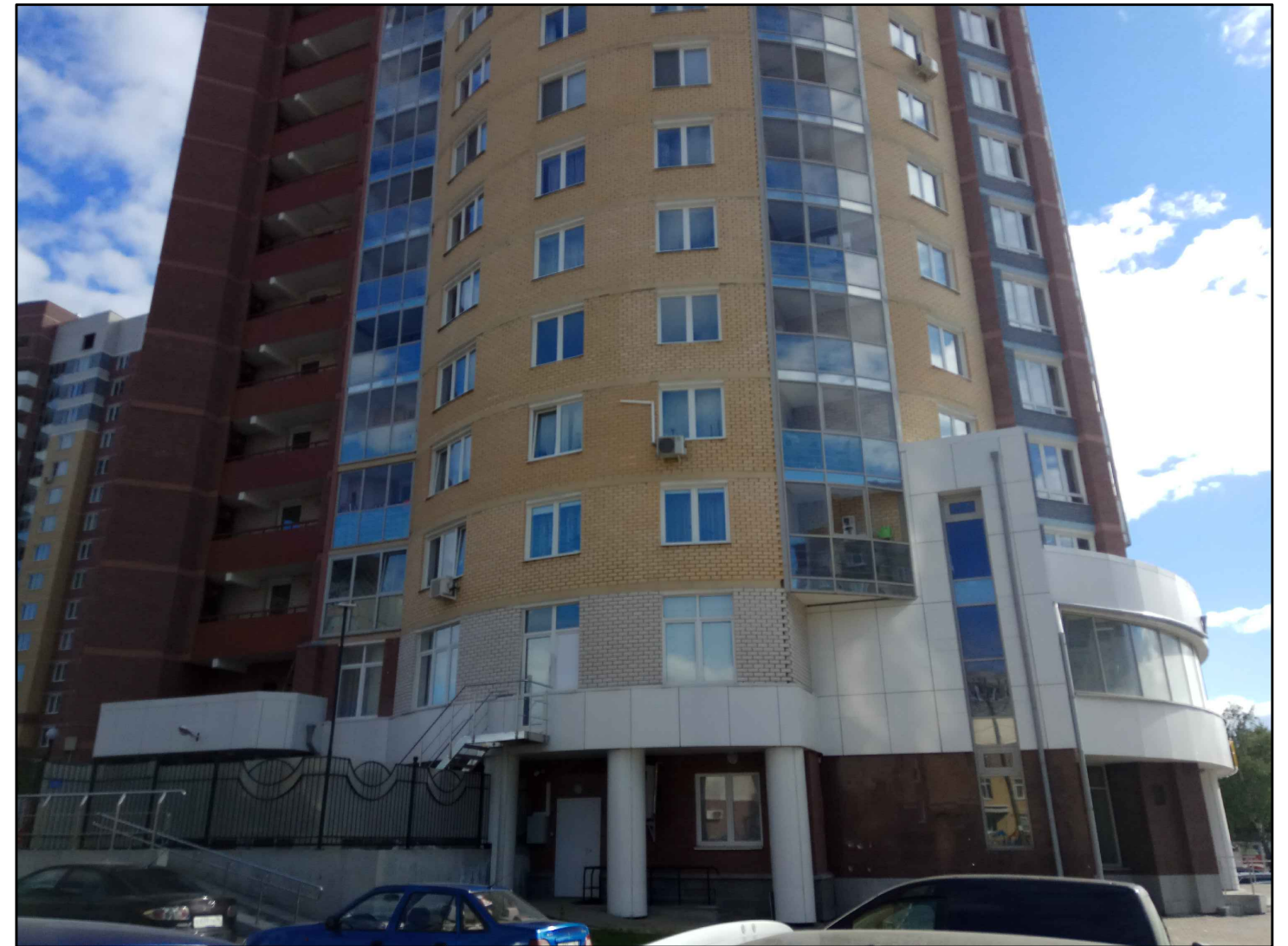
Вид № 4. Вид на фасад в уровне входных групп
